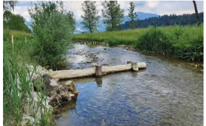
Stammbühne im Aabach Schmerikon. (Quelle: https://www.nipo.ch/reprofilierung-aabach-und-oekologische-aufwertung )
